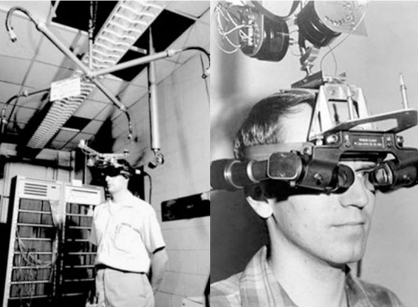
First VR Headset "The ultimate display" Ivan Sutherland, 1965, MIT Lincoln Lab.
